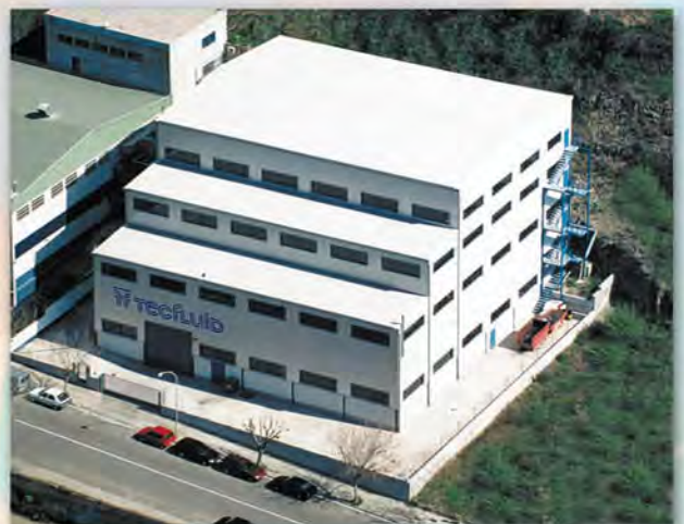
Edificio construido en 2001
